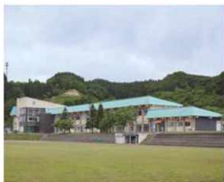
小学校をリノベーションした、西目屋工場。
