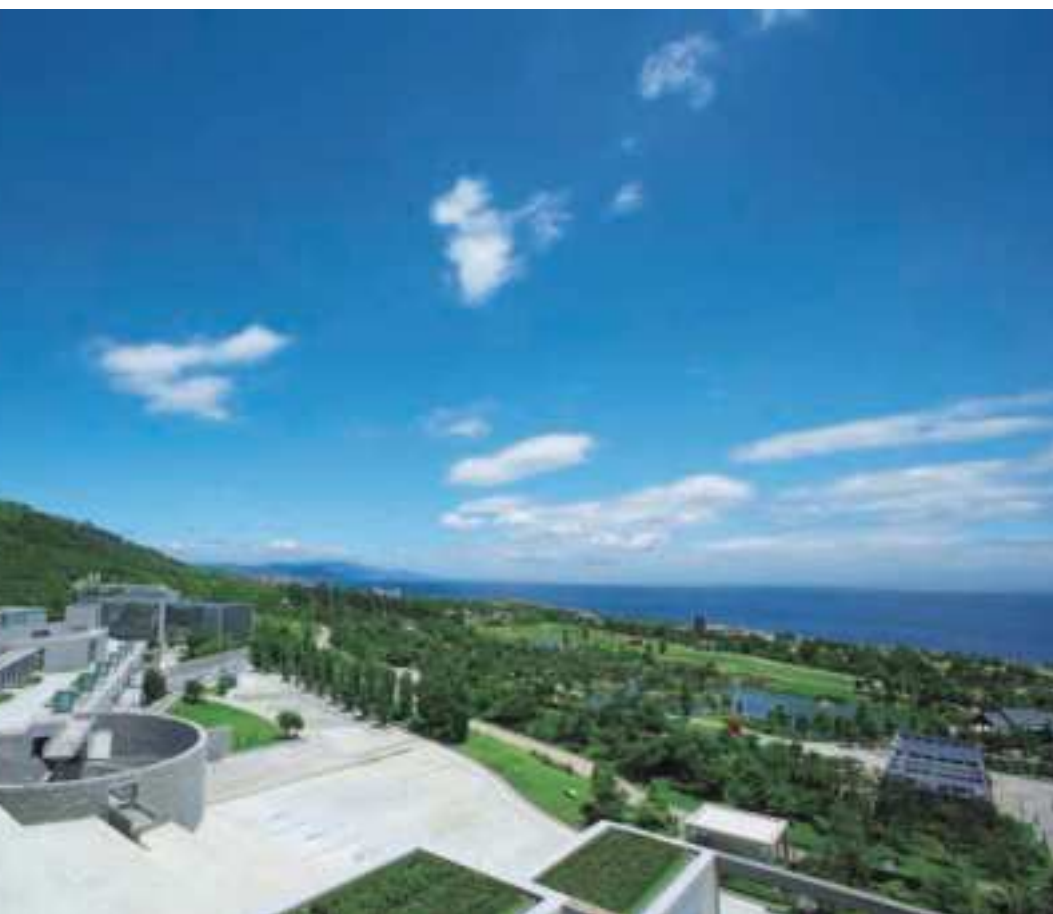
↑雄大な自然に囲まれた『淡路夢舞台』。
