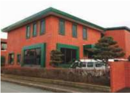
レンガ模様の壁面に、緑のルーフが映える リンベル グルメファクトリーの外観
