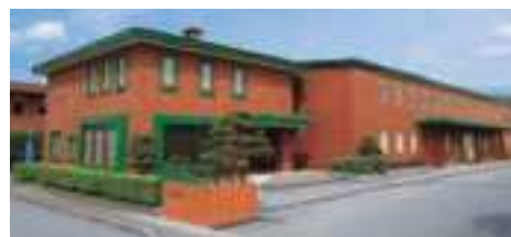
約722平方メートルに及ぶ自社倉庫内は、8台の空調機と5機の温度センサーで365日24時間、常に摂氏15度前後に保たれています。
