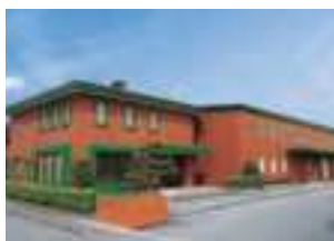
約722平方メートルに及ぶ自社倉庫「リンベル グルメファクトリー」内は、8台の空調機と5機の温度センサーで365日24時間、常に摂氏15度前後に保たれています。
