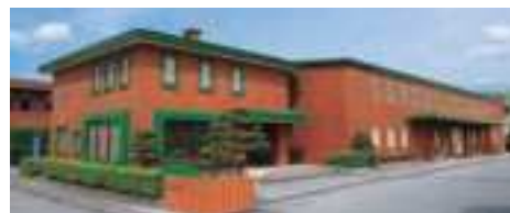
約722平方メートルに及ぶ自社倉庫「リンベル グルメファクトリー」内は、8台の空調機と5機の温度センサーで365日24時間、常に摂氏15度前後に保たれています。
